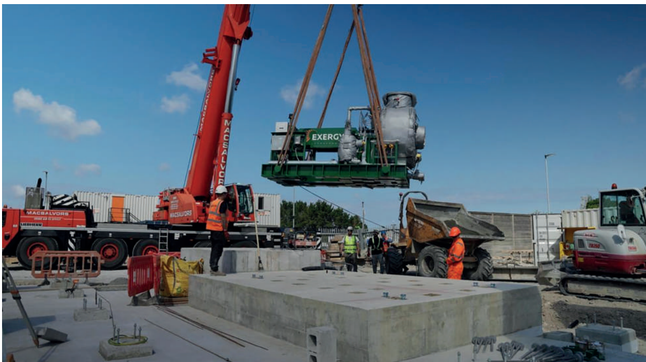
INSTALLAZIONE DELLA TURBINA RADIALE OUTFLOW DI AA NELL'IMPIANTO DI UNITED DOWNS
