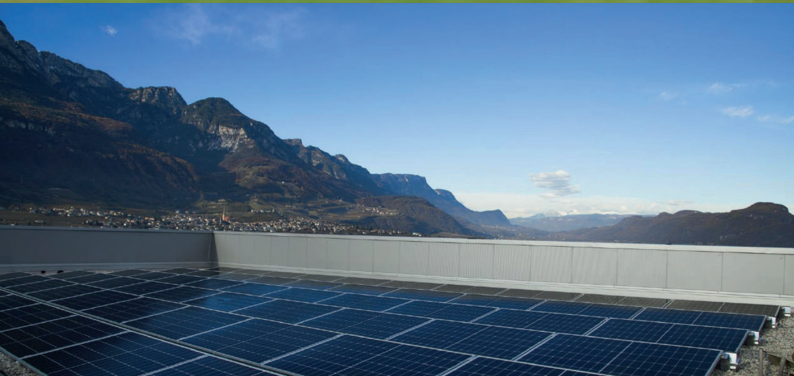
CENTRO LOGISTICO ZERO IMPACT LOGISTICS HUB DI WÜRTH ITALIA DI EGNA, AUTOSUFFICIENTE DAL PUNTO DI VISTA ENERGETICO.
